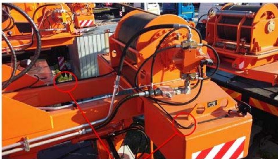
Электроразводка в жгутах
